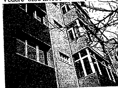
Vedere bloc nr.110 vedere(fata)
