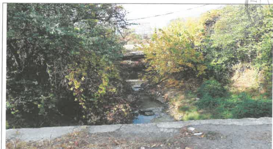
Foto 1 - Aspect al malurilor paraului amonte de pod 3
