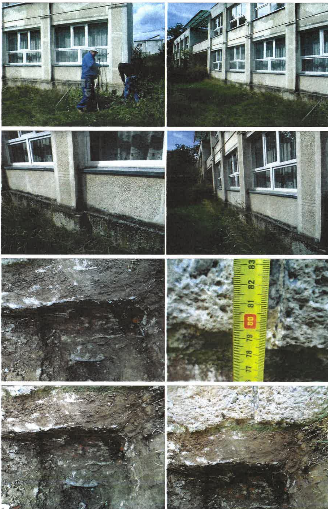
Foto 17- 24 Imagini cu clădirea existentă, și sdâncimea de fundare a acesteia
