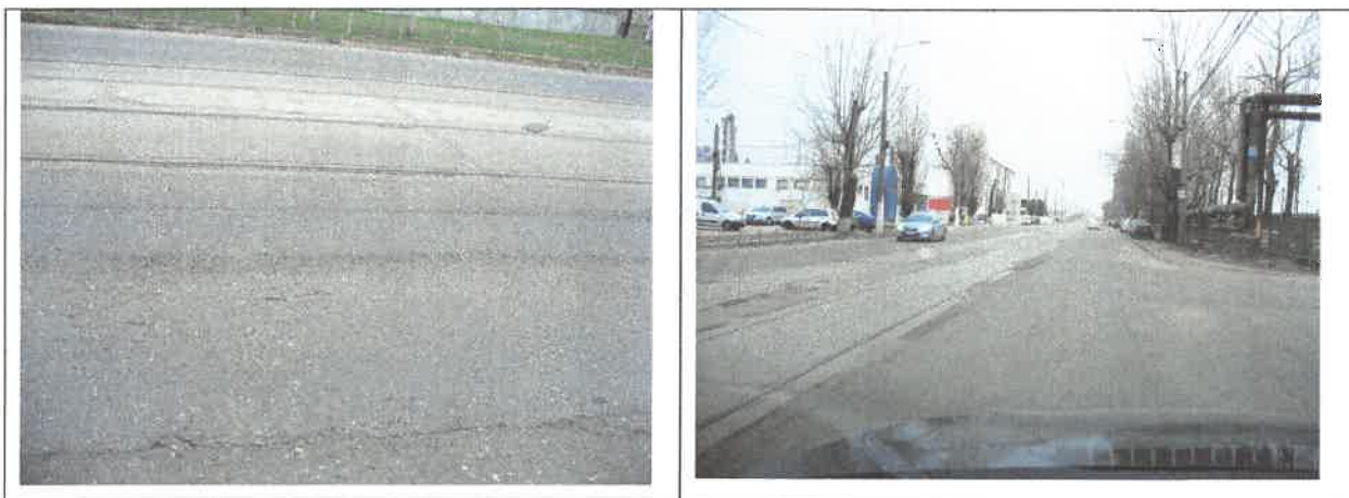
Stratul de uzura este într-o stare rea în special la rostul cu dalele pentru cf tramvai.
