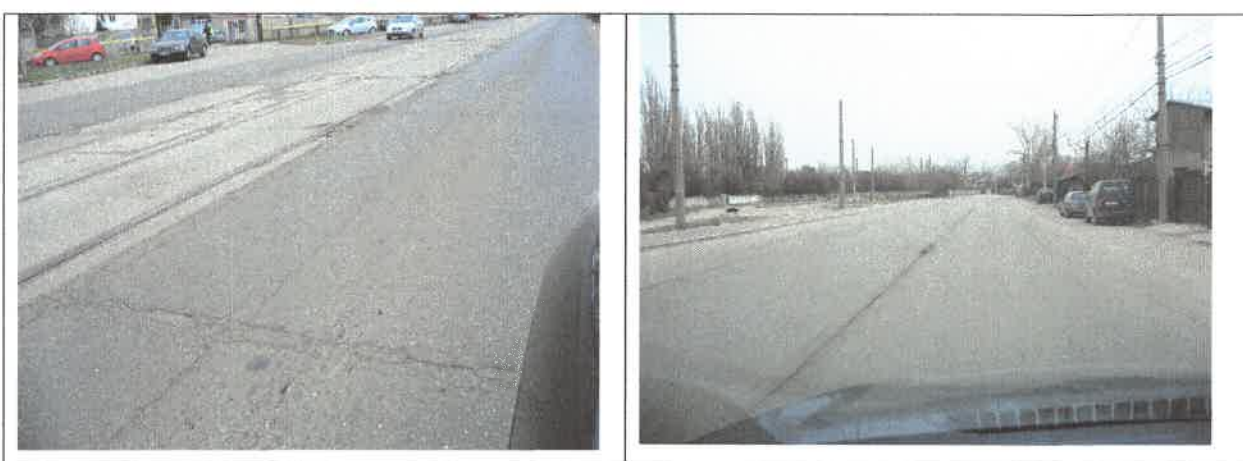
Structura semirigida este vizibilă la suprafața prin rosturile de la betonul de ciment transmise prin reflexie la suprafața.
