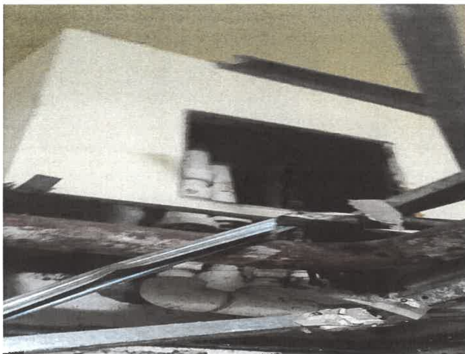
Fig. 3 Coloanele de agent termic prezintă scurgeri și urme de scurgeri, nu sunt izolate
