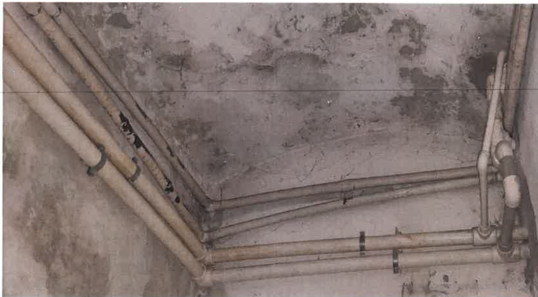
Fig.1 Aspectul și poziționarea conductelor de agent termic în subsol
