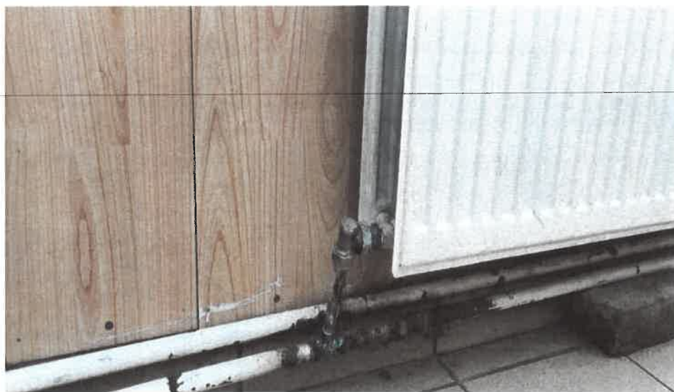
Fig. 16. Robinet nefuncțional, prezintă scurgeri, CRP este incomplet
