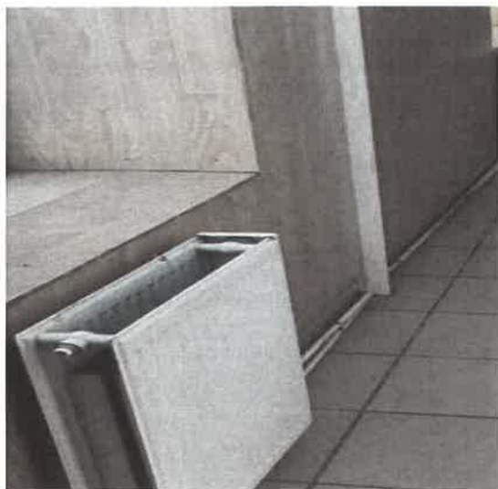
Fig. 19. Lipsesc elemente componente ale corpurilor de încălzire, prezintă risc de accidentare/lovire, CRP sunt conectate la partea inferioară reducându-li-se puterea nominală, robinet tur/retur deteriorat, nemanevrabil, prezintă scurgeri.
