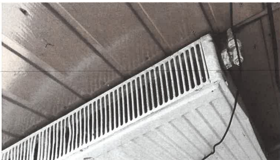
Fig. 14. Robinet nefuncțional (tur si retur), CRP este lipit de peretele suport reducându-i-se puterea termică
