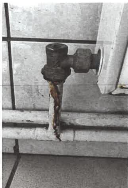
Fig. 18. Robinet retur deteriorat, nemanevrabil, prezintă scurgere de agent termic din corpul său si de la infiletare, se observă rugină la partea inferioară a corpului de încălzire
