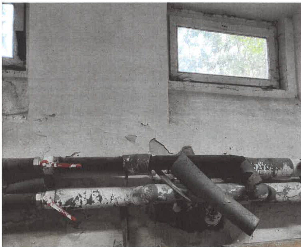
Fig. 2 Conducte si armături de manevră deteriorate. Lipsește izolația de pe conducte. Manevrarea armăturilor este îngreunată.
