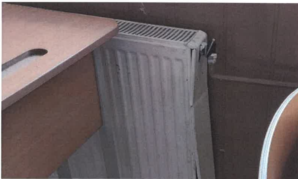
Fig. 11. CRP lovit, Elementele de protecție sunt lovite, unele lipsesc
