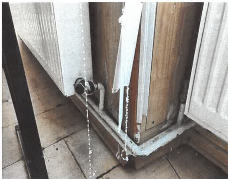
Fig. 15. Robinet nefuncțional, prezintă urme de scurgeri, distanța față de perete este prea mică
