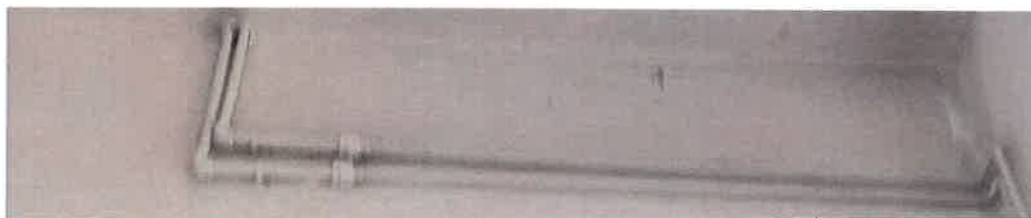
Fig. 12. Conductele nu au suficienți suporturi
