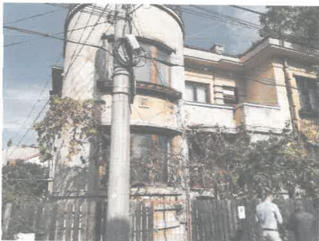
Vedere exterior construcție
